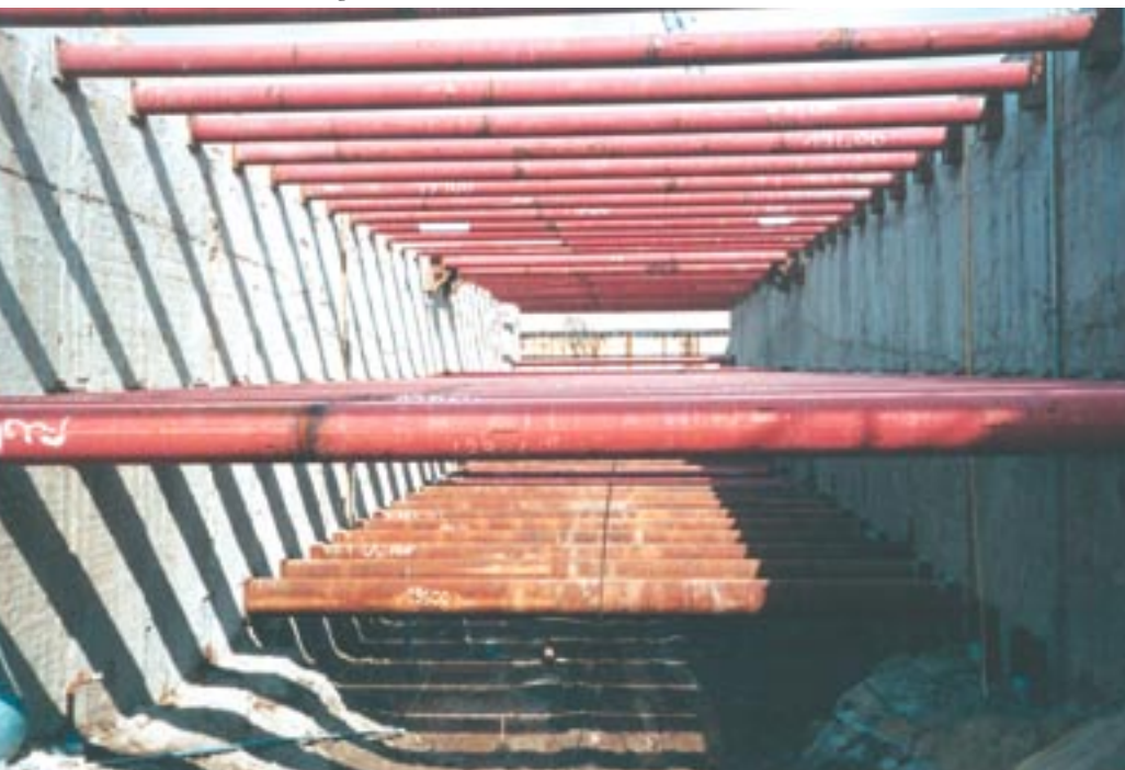
Rohrsteifen im Hamburger S-Bahnhof
