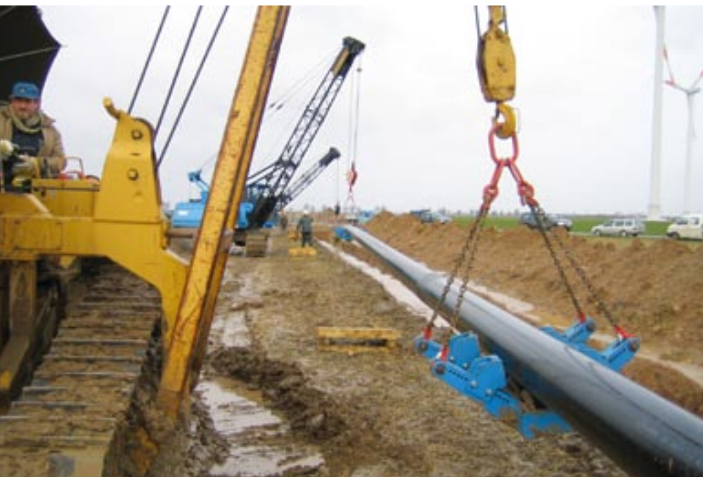
Absenken der Rohrleitung
