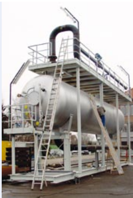
Entgaser in der Vormontage
