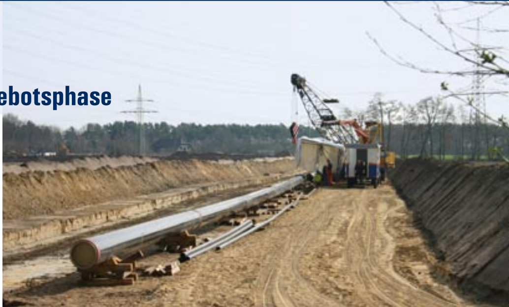
Schweißen der DN 500 Gashochdruckleitungen für die Feldleitung nahe der Verdichterstation
