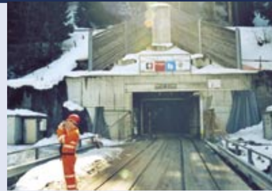
Portal des Zugangsstollens: Durch dieses Nadelöhr müssen alle Transporte vom und zum Schacht
