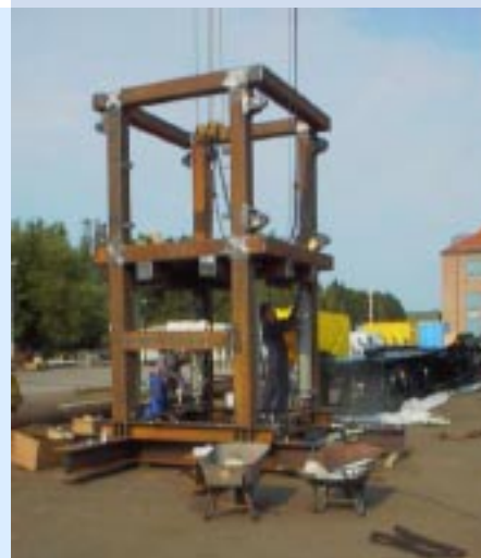
Die Rickless Intervention Unit kommt auf einer KBB- Bohrung in Portugal zu ihrem ersten Einsatz. Max Hubkraft: 200 to Max Hub: 1,20 m
