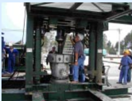
Der Hub der Hydraulikstempel löst das erste Rohr aus dem Bohrlochkopf. Alle weiteren Rohre werden dann mit Hilfe eines Autokranes angehoben und entsraubt.
