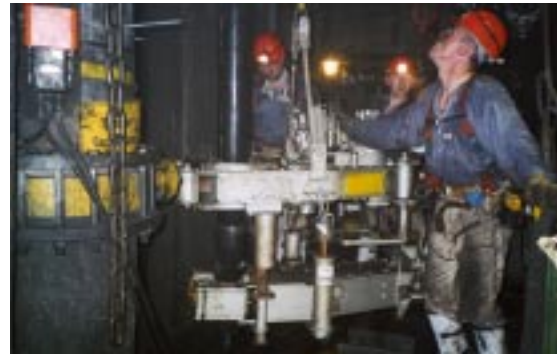
Verschrauben der Einzelrohre
