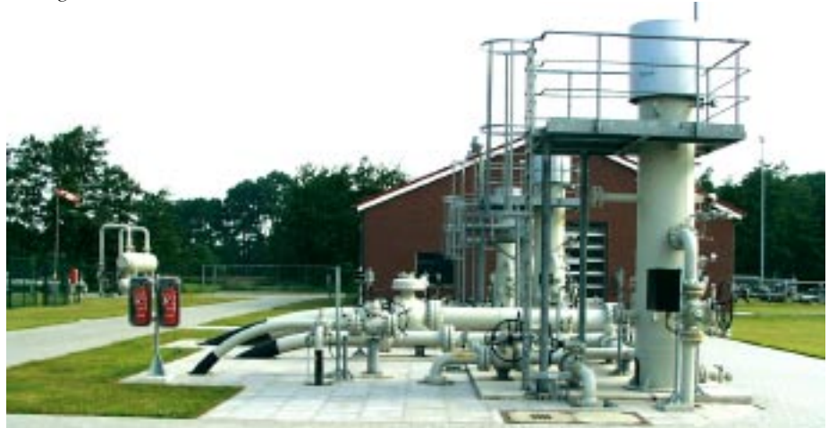
Leitungsaufführungspunkte mit stehendem Staub- und Flüssigkeitsabscheidern
