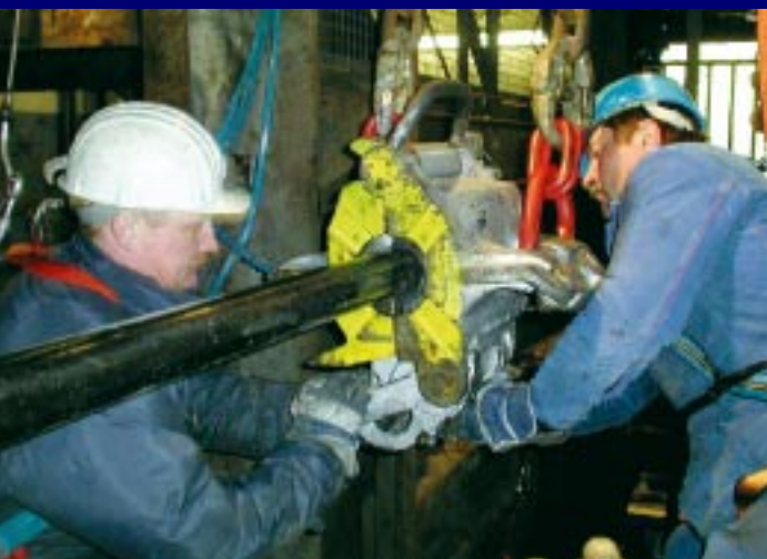
Anschlagen eines Einzelrohres mit dem Elevator
