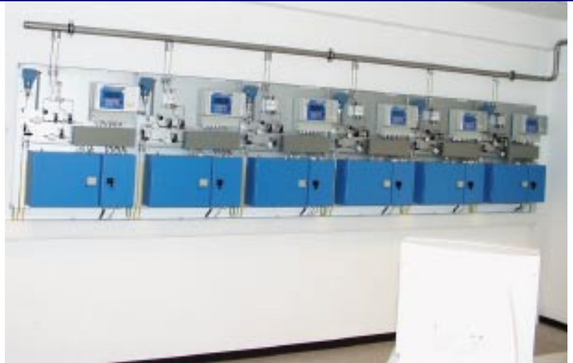
Gasqualitätsmessung zur Regelung von Gasströmen
