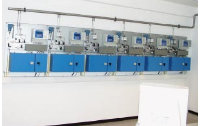
Gasqualitätsmessung zur Regelung von Gasströmen
