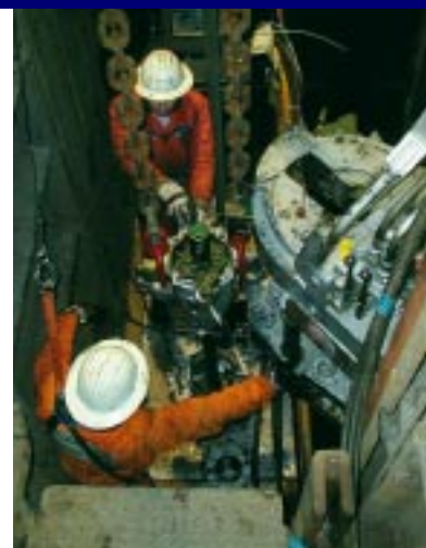
Verschrauben der Rohrleitung mittels Hydraulik - Zange
