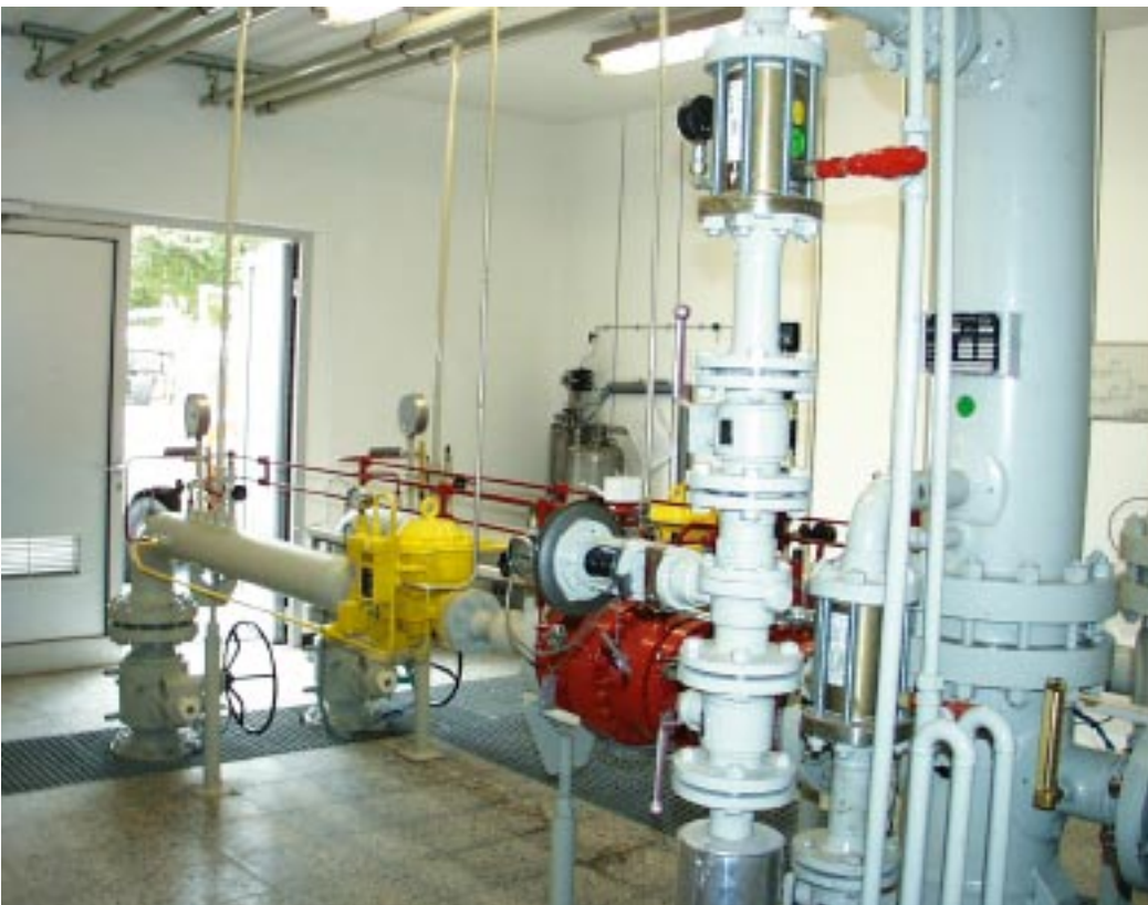
Gasdruckregelstation
