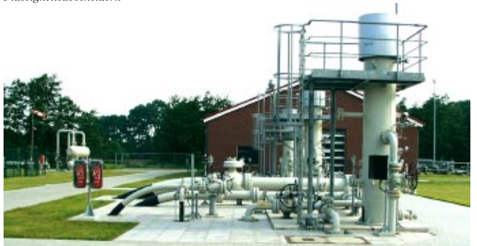
Leitungsaufführungspunkte mit stehendem Staub- und Flüssigkeitsabscheidern
