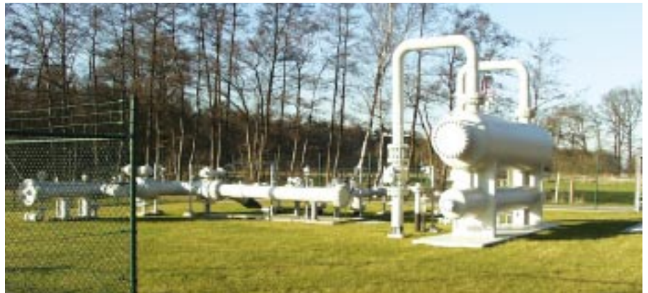
Gasfilterung einer ankommenden 18" Gasleitung mit liegendem Staub- und Flüssigkeitsabscheidern
