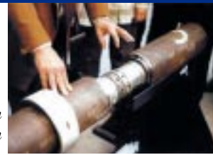
Schweißen von BUBI Rohren
