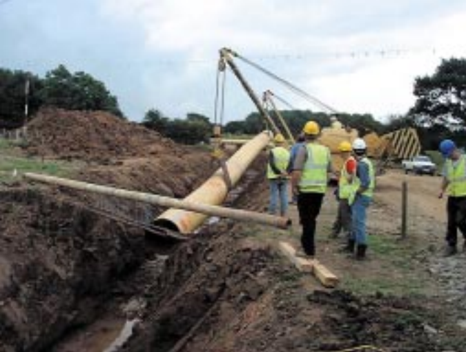
Absenken der Pipeline
