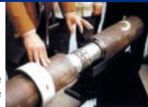
Schweißen von BUBI Rohren
