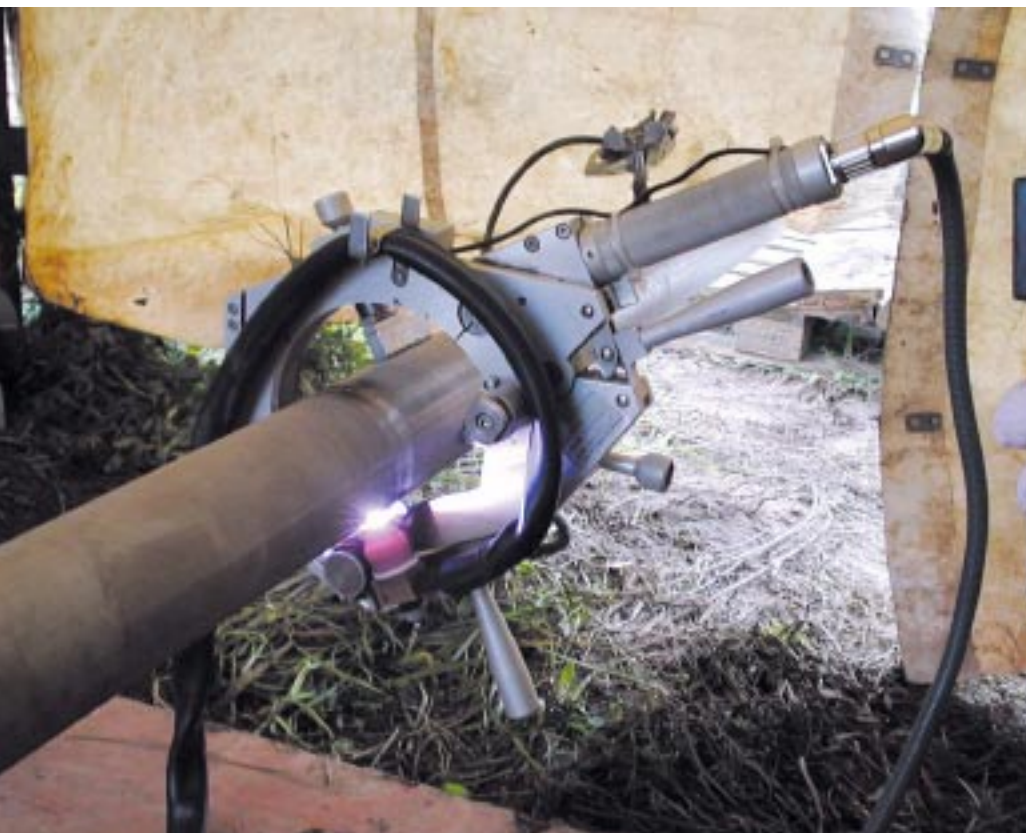
Schweißen unter Baustellenbedingungen
