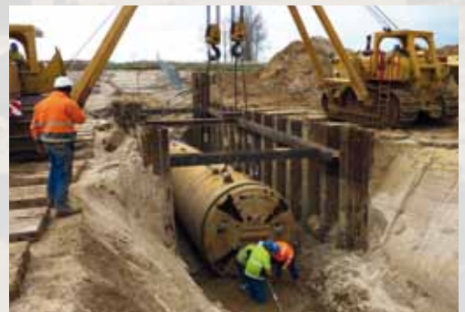
Bergung des Bohrkopfes
