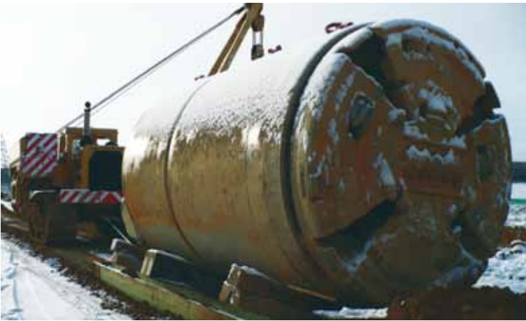
Tunnelbohrmaschine auf Schlittenkonstruktion
