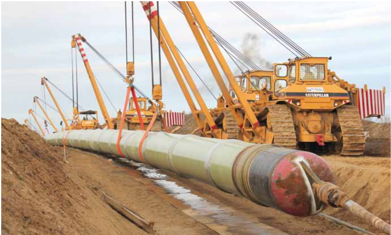
Rohrstrang bereit zum Einzug
