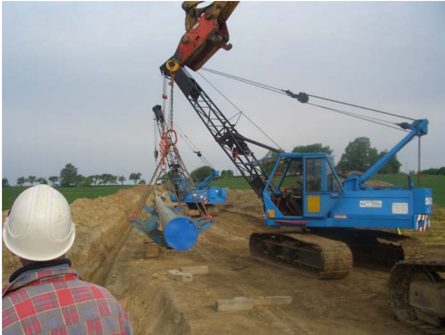
Absenken des vorgeschweißten Rohrstranges DN 300
