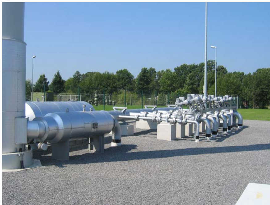
Ausblasesystem mit Ausbläser und Schalldämpfern
