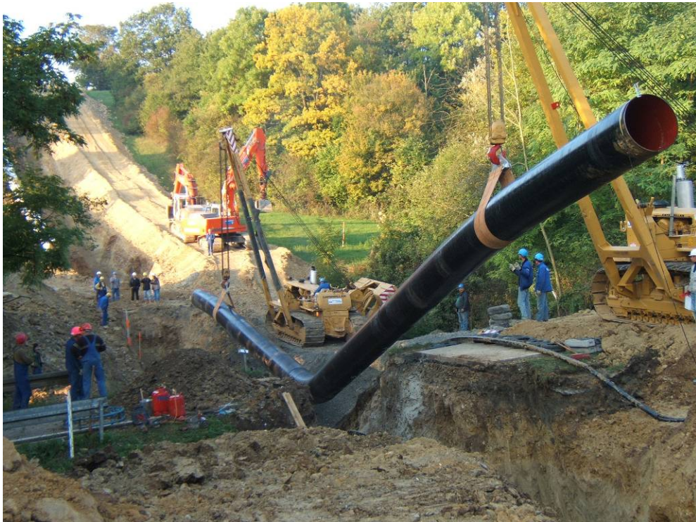
Einbau einer Rohretage
